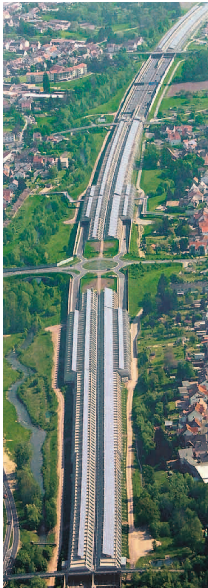
Die Betonhülle der Autobahn bei Aschaffenburg ist 2,7 Kilometer lang, ähnlich wie der Elbtunnel. FOTOS: EWERK GOLDBACH-HÖSBACH
