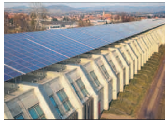
Der Autobahn-deckel wurde gebaut, um Anwohner vor dem Verkehrslärm zu bewahren. Jetzt ist er mit Solarzellen gespickt. Das Potenzial für Ökostrom an Autobahnen gilt als gewaltig.
